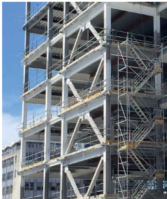
Fig. 3: Reconstruction à Christchurch NZ 2016
