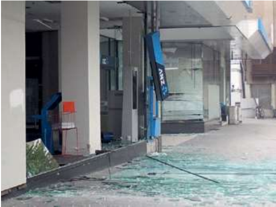
Abb. 1: Bankfiliale in Christchurch am 22. Februar 2011
