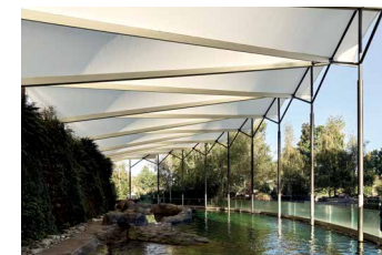
Beschattungsanlage Tierpark Bern
