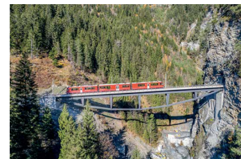
RhB Ersatzneubau Castiellerviadukt
