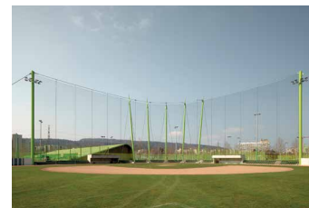
Sportanlage Heerenschürli: Ballfang Baseball-Anlage
