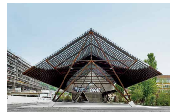
Koch-Park und Kohlenlagerhalle
