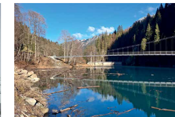
Dienstbrücke Stausee Egschi
