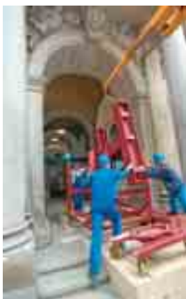
Der Stahlbau wurde im Werk vorgefertigt, in handlichen Teilen angeliefert und mit Rücksicht auf den laufenden Bürobetrieb ohne Lärm- und Staubemissionen montiert.
