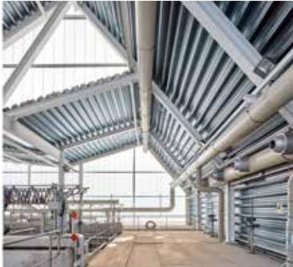
Dans la station d'épuration de San Claudio (voir p. 14), l'enveloppe de la charpente métallique est constituée d'une combinaison de longues tôles d'aluminium et de plaques de polycarbonate.
