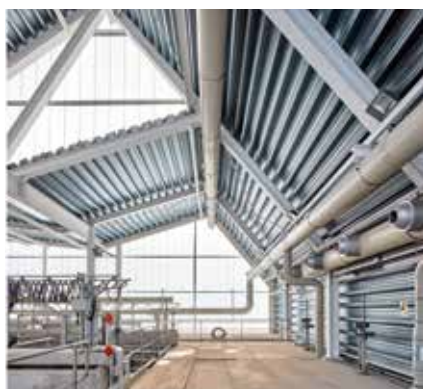
Bei der Kläranlage in San Claudio (vgl. S. 14) wird die Stahlstruktur mit einer Materialkombination aus Aluminiumtrapezblechen und Polycarbonatstegplatten umhüllt.
