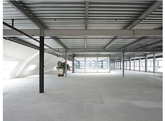
Abb. 1: Offene Räume mit wenigen Stützen dank Verbundbau
