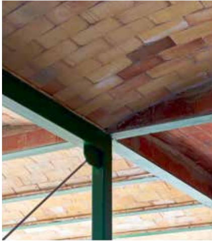
Das Prinzip der Kappendecke ins 21. Jahrhundert transferiert: Das «Brick Vault House» bei Valencia (ES) ist räumlich geprägt von der Kombination eines Stahlskeletts mit auf den Trägern liegenden, flachen Ziegelgewölbten.
