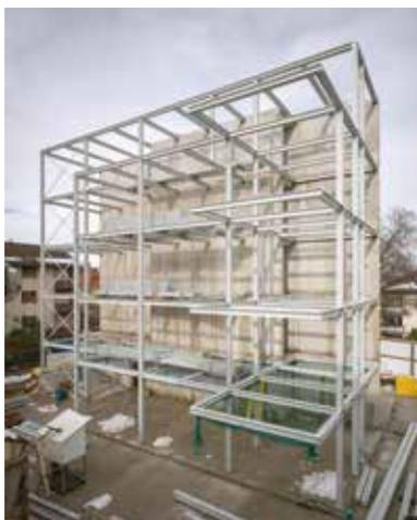
Sur l'Herbstweg à Zurich, le cabinet Graser Troxler Architekten a conçu un immeuble d'habitation qui exploite l'ensemble des possibilités et des avantages de la structure en acier. Le noyau est certes massif, mais la structure métallique filigrane permet une adaptation des configurations et un futur réemploi des éléments de construction.
