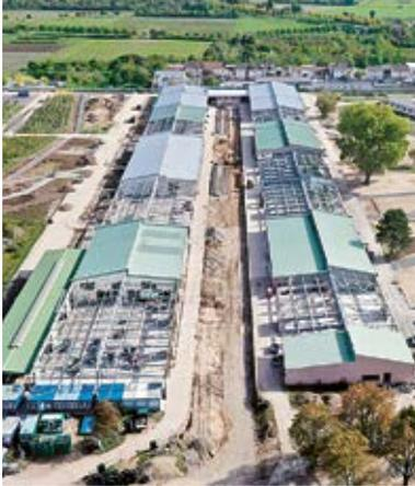
Dritter Nutzungszyklus: Die U-Halle in Mannheim (D) ist aktuell Teil der Bundesgartenschau BUGA 23. Die US-Armee, die die Halle nach dem Zweiten Weltkrieg von der deutschen Wehrmacht übernommen hatte, fügte der Stahlbetonstruktur eine Stahlfachwerkkonstruktion hinzu, wodurch die U-Form ausgebildet wurde – ideal zur beidseitigen Be- und Entladung des im zentralen Hof haltenden Güterzugs.
