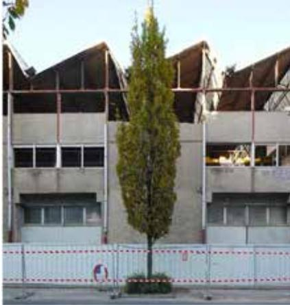
Die stählerne Dachkonstruktion der Halle 6 Ost auf dem Alstom-Areal in Nantes hat es nicht geschafft: Sie wurde abgebrochen und durch eine fast identische neue Konstruktion ersetzt (vgl. S. 21). Eine ähnliche Sheddachkonstruktion in der daneben liegenden Halle 6 West wurde aber instand gesetzt und prägt das Gebäude und den Aussenraum zwischen den beiden Hallenteilen massgeblich mit (ab S. 19).
